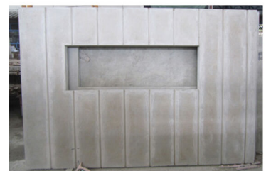
แผ่น Precast (แผ่นคอนกรีตหล่อสำเร็จ)
