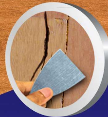
อุดรอยแตก ร่องไม้
